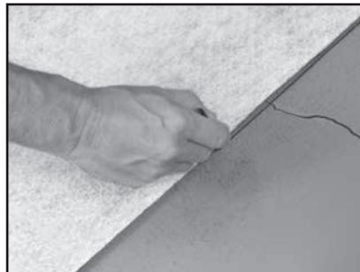
1.4 Reserve las secciones precortadas (o rollos enteros) de Mapeguard 2. Siga las instrucciones de instalación en el Paso 2.3.
