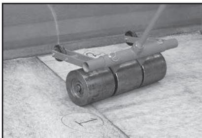
**4.5** Retire las arrugas u objetos que hayan quedado atrapados bajo la membrana con una trincheta y, luego, repare.
