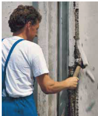
Demolición del concreto degradado
